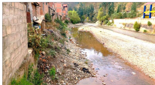
FIGURA N°02: Tramo del Río Huallaga con socavación en la margen izquierda, afectando la base de un muro de contención de una vivienda. El cauce muestra un lecho ancho con acumulación de material granular.
