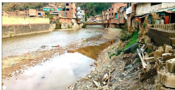
FIGURA N°01: Vista del Río Huallaga en una zona densamente poblada, mostrando un cauce con baja capacidad por acumulación de material de descolmatación. Se observa una ribera con escombros, vegetación y cercanía a viviendas.
